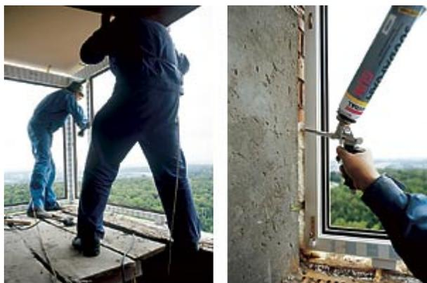
Специалисты заделывают швы с помощью монтажной пены
